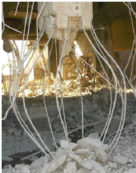
A sinistra, il particolare di una demolizione meccanica. A destra, l'effetto dell'esplosivo su un pilastro in cemento armato
